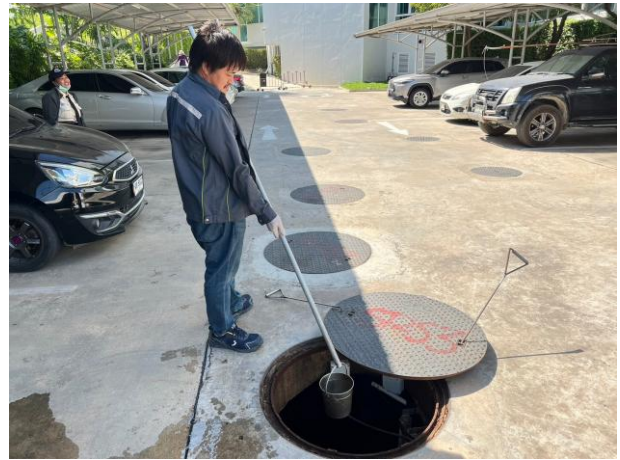
จุดรวมน้ำออกเข้าระบบบำบัดน้ำเสีย
